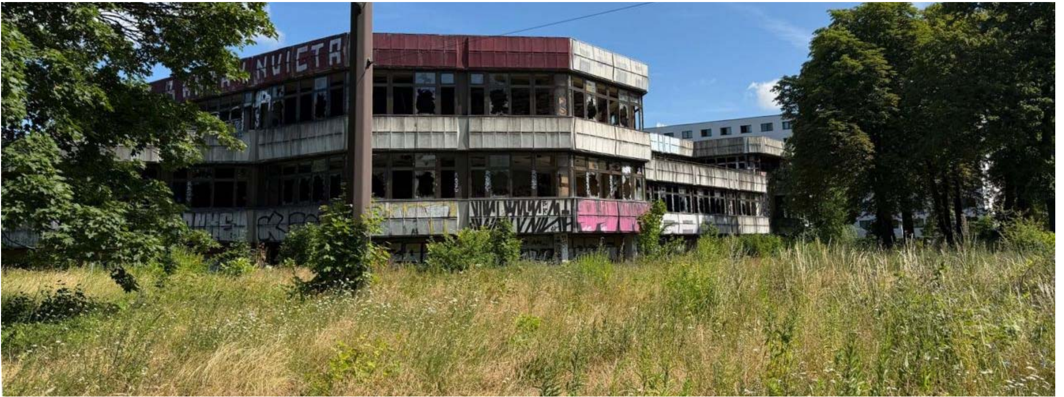
Das ehemalige DDR-Sporthotel am Hohenschönhauser Tor kurz vor dem Abriss. Auf dem Areal an der Konrad-Wolf-Straße soll ein neues Quartier mit Wohnungen, Gewerbe und einer Kita entstehen. / © Foto: ENTWICKLUNGSSTADT
