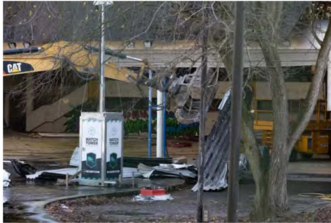
Der SEZ-Abriss: Auch im Innenhof begann der Bagger mit den vorbereitenden Arbeiten. Pressefoto Wagner
