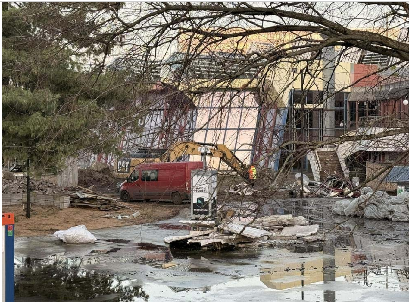
Der Bagger bei der Arbeit am Donnerstag. © Robert Klages
