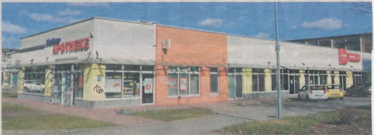
Der südliche Teil der Kleeblatt-Passage soll erhalten bleiben. Dort befindet sich unter anderem eine Apotheke. Foto: Philipp Hartmann
